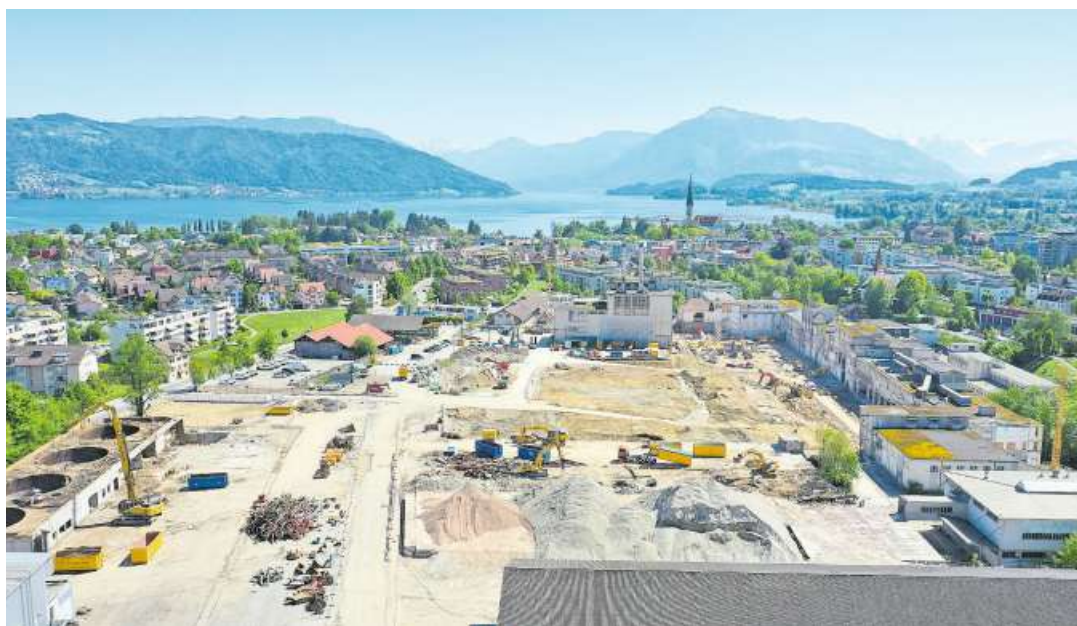
Die Abbrucharbeiten des Areals in Cham.
